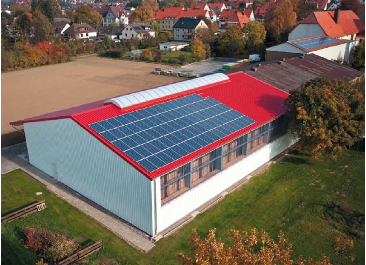
Rückansicht Camena mit neuer Lagerhalle
